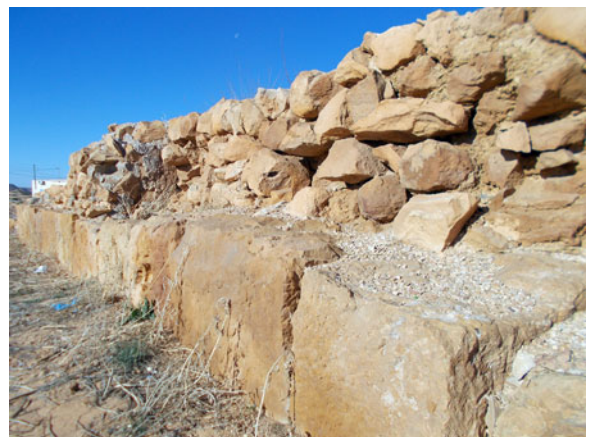
Figure 16. remontée capillaire.
