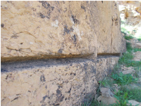
Figure 10. Vue de détail sur le levage.
