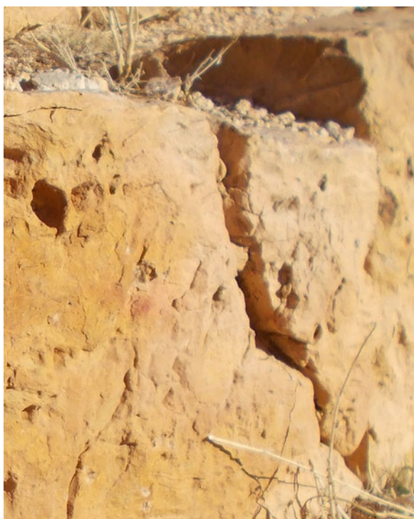
Figure 17. Fissure due au phénomène du gel et dégel.
